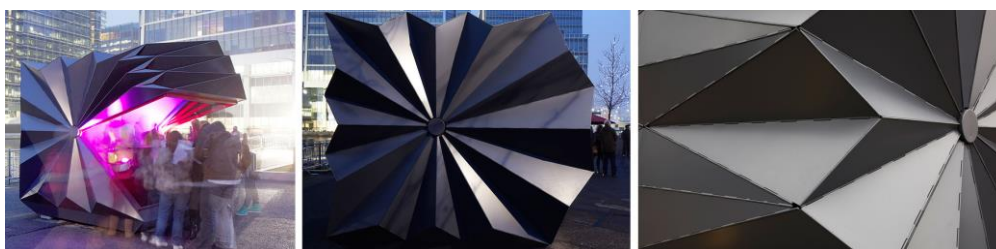
Figura 5 - Canary Wharf Kiosk: aberto, fechado e detalhe das dobradiças metálicas. Fonte: Make Architects (2015)
