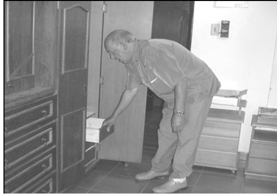
Figura 19 – Altura da gaveta muito baixa em relação ao piso
