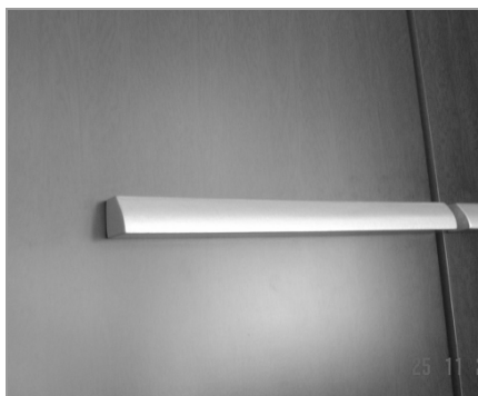
Figura 13 – Configuração do puxador que dificulta a apreensão da mão
